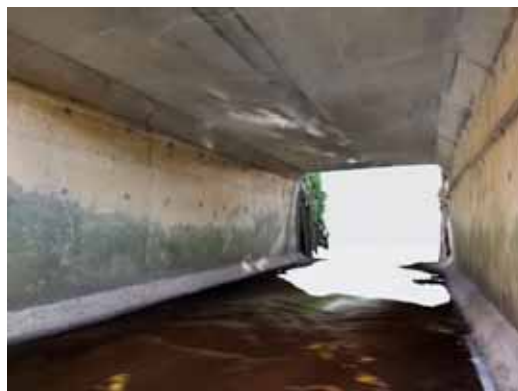
写真-1 スキャンしたボックスカルバート
