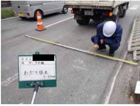
写真-5 わだち掘れ量の計測状況
