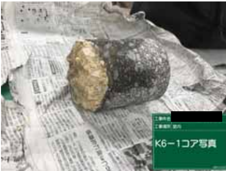
写真-6 基層まで損傷が及んだコア
