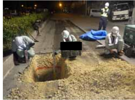
写真-8 開削調査状況
