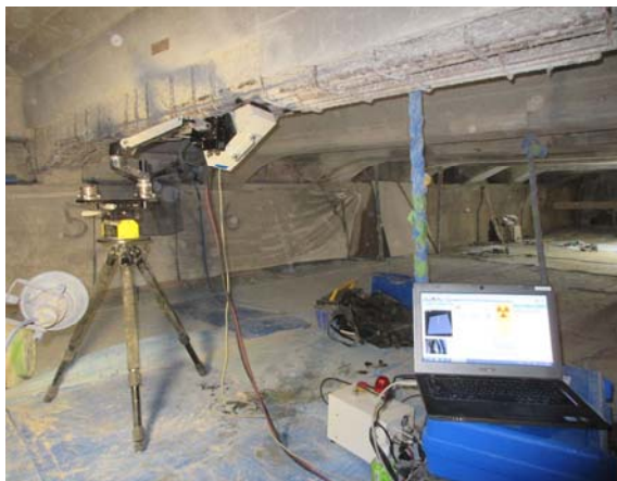
図-10 応力測定状況
