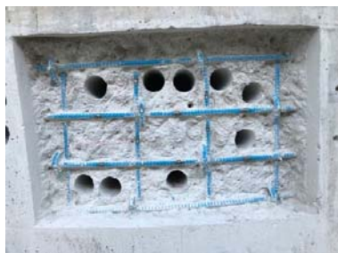
図-3 測定前のはつり出しおよび電解研磨状況
