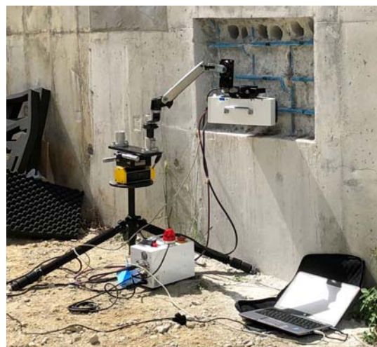
図-6 応力測定状況
