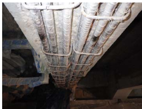
図-5 鉄筋はつり出し状況(断面修復)
