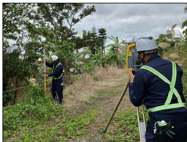
写真-1 TS 観測状況
