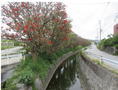
写真-1 既設護岸の状況写真
