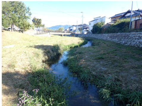
写真-6 他県の多自然川整備状況
