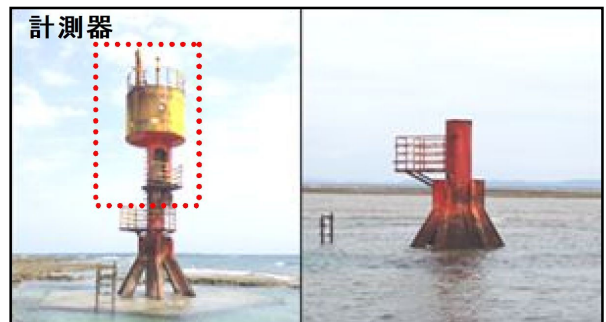
写真-2. 計測器の撤去前(左)と撤去後(右)
