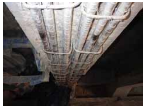
図-5 鉄筋はつり出し状況(断面修復)
