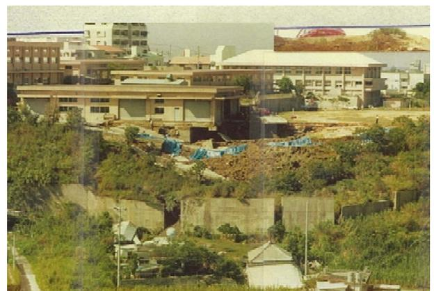
写真-1. 隣接箇所の地すべり発生状況
