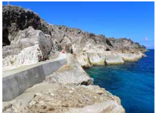
写真-11 網取堤完成後(R2年9月30日撮影)
