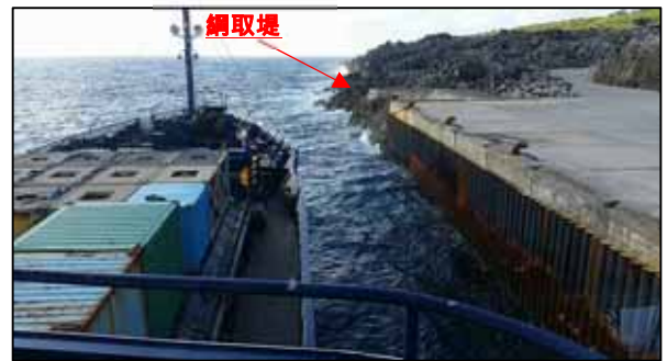
写真-2 綱取堤を利用する事例
