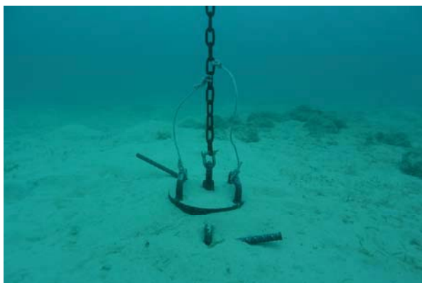
写真-4 ブイの海底固定状況
