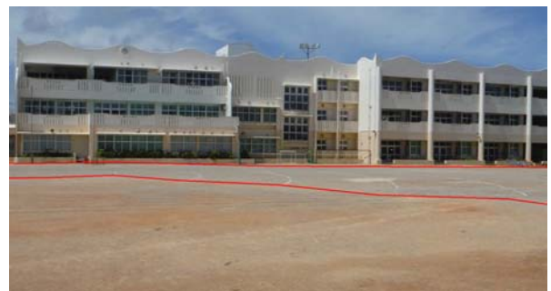
写真-2 露出している碎石の状況
