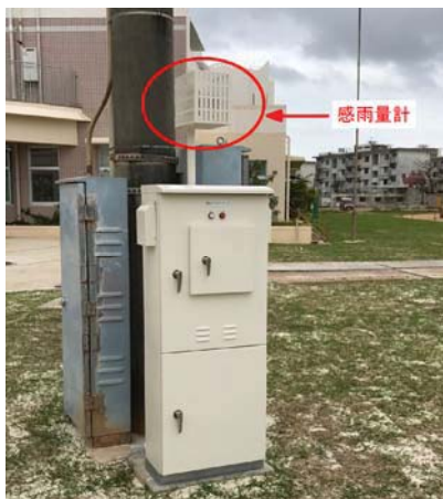
写真-9 新設スプリンクラーの起動基
