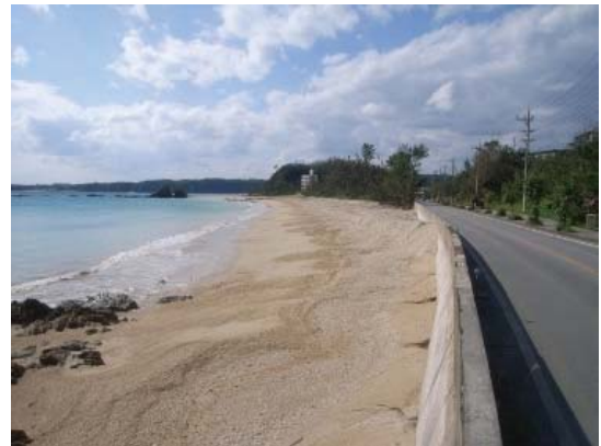
写真-3 A 区間の護岸の状況
