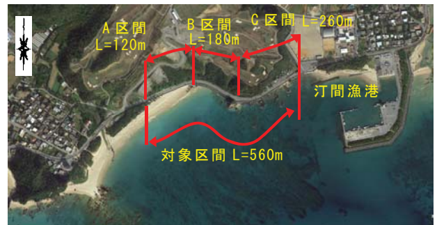
写真-2 設計対象区間の空中写真
