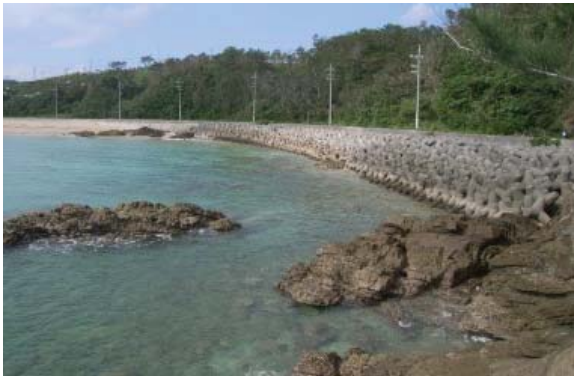
写真-4 B区間の護岸の状況
