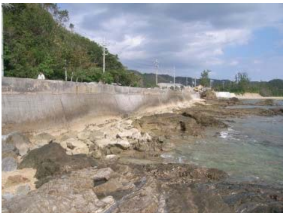
写真-5 C区間の護岸の状況
