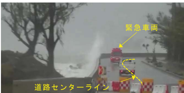
写真-6 波浪時の越波状況(C区間)
