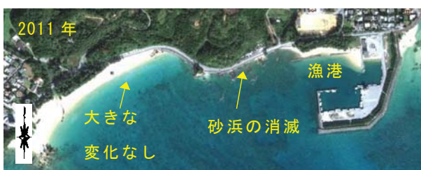
写真-7、8、9 空中写真による海浜の比較
