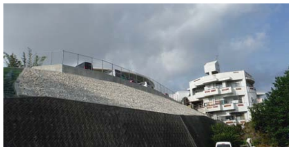
写真.4 完成後の法面状況
