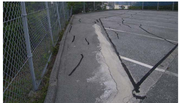
写真.2 法面上方のアスファルト舗装状況
