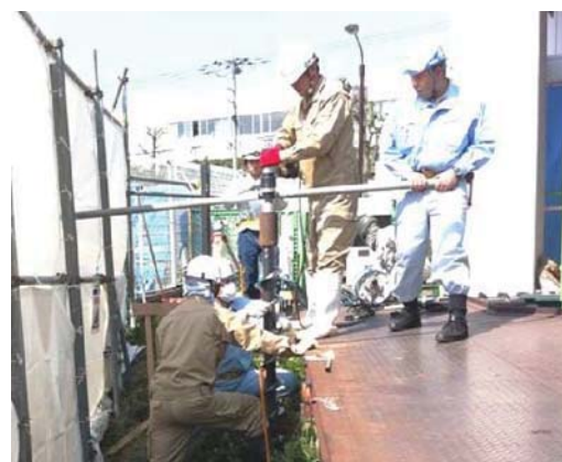
写真-2 小型回転杭(施工例)
