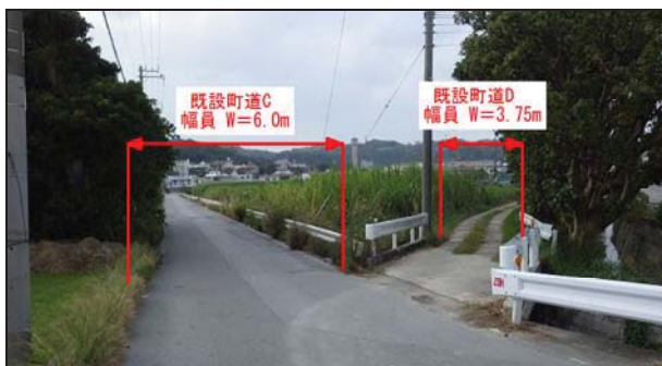
写真-3 既設町道 C、D の状況
