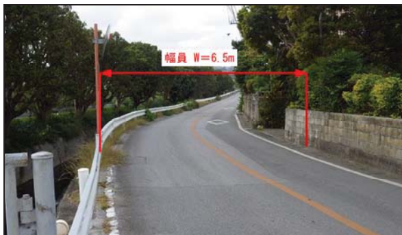
写真-2 既設町道 B の状況
