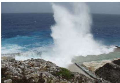
写真-1 波浪の影響を受ける現地岸壁
