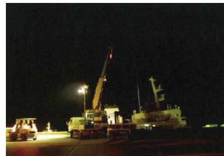
写真-3 夜間作業状況-1
