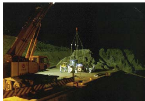
写真-4 夜間作業状況-2
