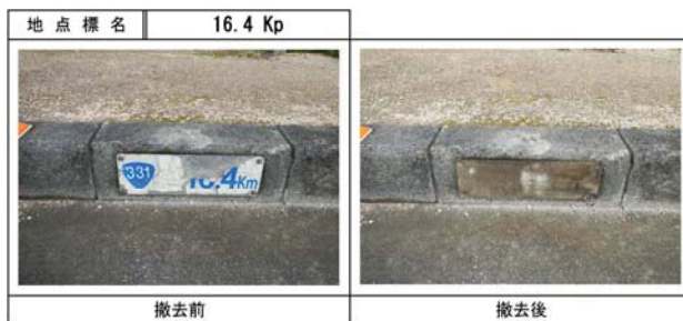
写真-4. 地点標撤去状況
