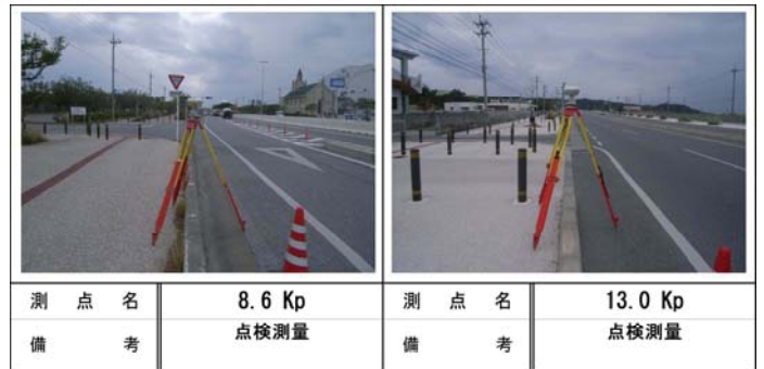
写真-3. 点検測量観測状況
