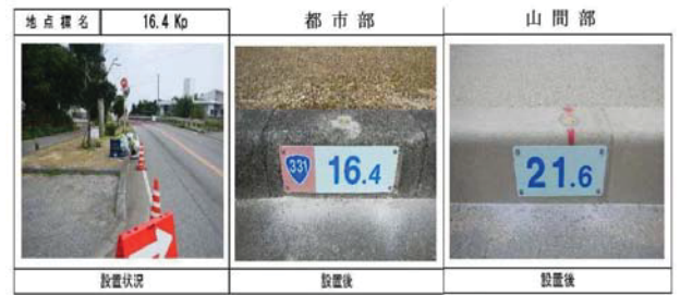
写真-5. 地点標設置状況
