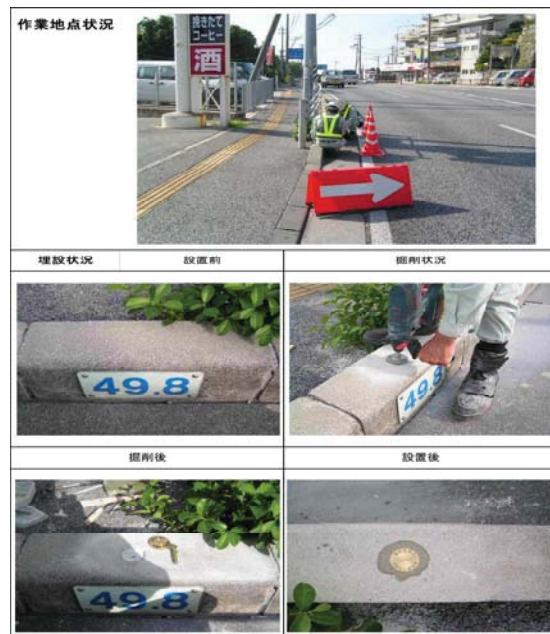
写真-1. 作業状況
