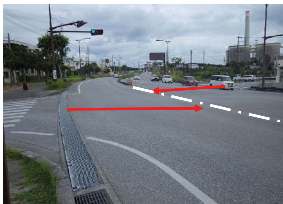
写真-3 交差点内の状況
