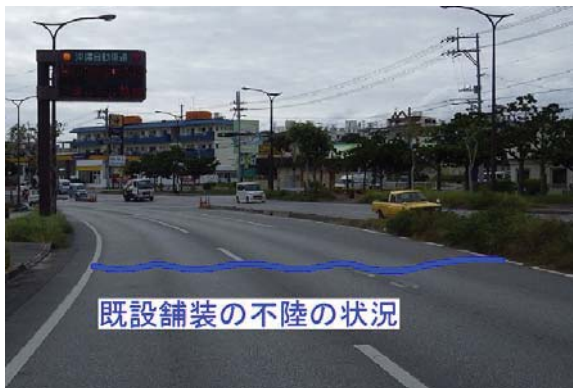
写真-4 交差点内の状況
