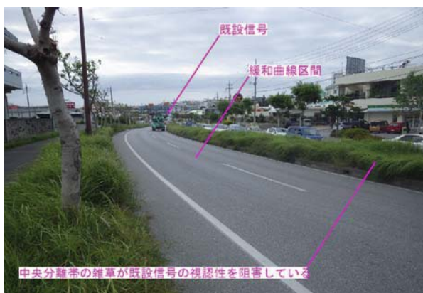
写真-1 交差点手前(約200m)の状況
