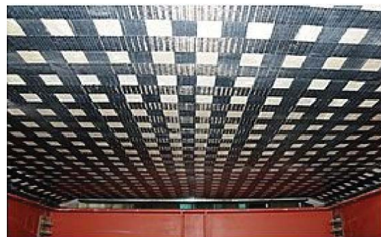
写真-5 連続繊維シート接着工法による施工例
