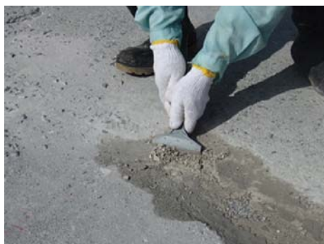
写真-2 スラブ上面(ノロ部)
