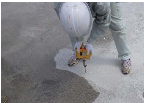
写真-3 反発度法による調査状況
