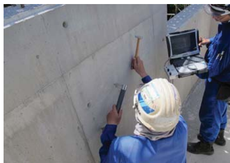
写真-4 衝撃弾性波試験の状況
