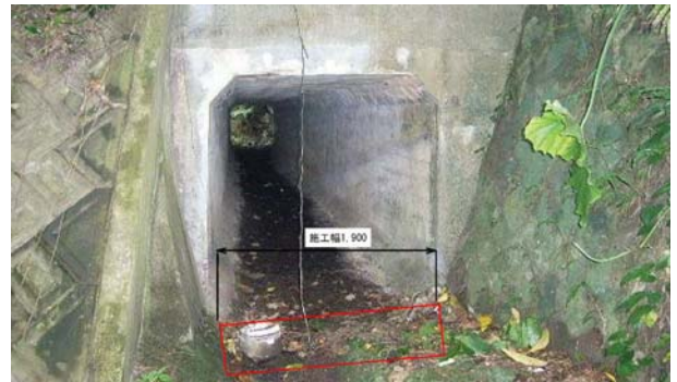
写真-6. 根固め工設置箇所
