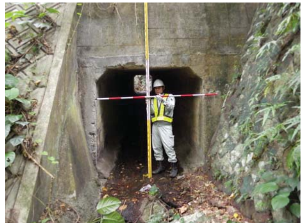
写真-1. ボックスカルバート吐口部
