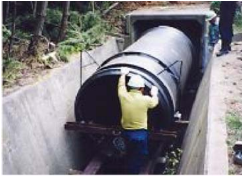
写真-4. 高耐圧ポリエチレン管挿入状況
