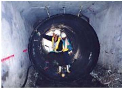
写真-5. 管更生工 施工状況
