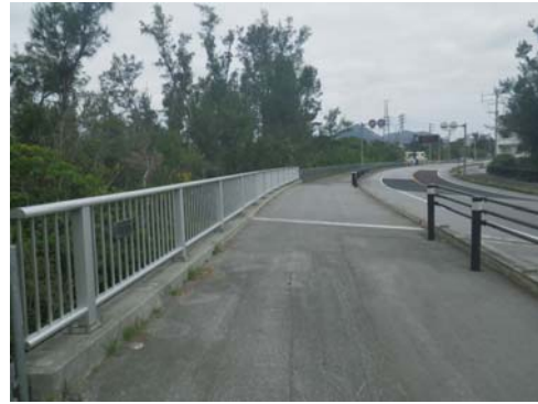
写真-6. 右側端部における歩行者自転車用柵の設置状況(B橋)
