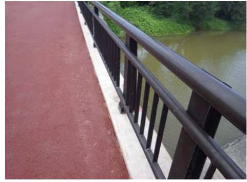
写真-3. 右側端部の防護柵の設置状況(A橋)
