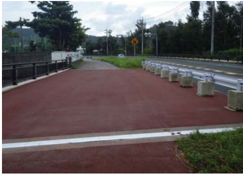
④ 写真-5. 北向け車線の歩車道境界における防護柵の設置状況 (A 橋)
