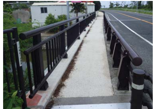
写真-4. 左側端部と北向け車線の歩車道境界における防護柵の設置状況(A橋)
