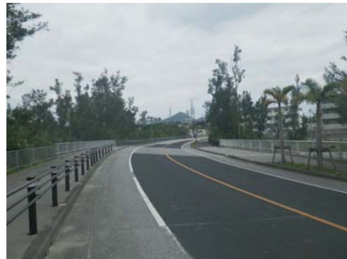
写真-7. 両車線の歩車道境界における防護柵の設置状況(B橋)
