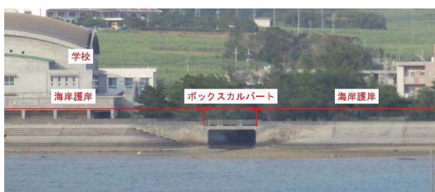
写真-1 対象構造物全景
