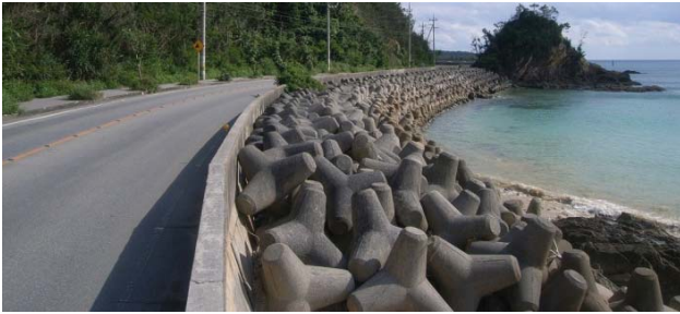
写真-4 A区間の状況
