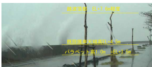
写真-7 現況の越波状況
