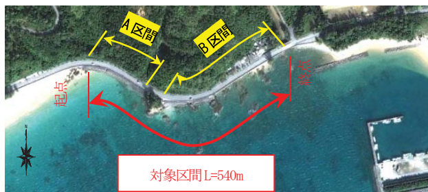
写真-1 対象区間の空中写真(Google Earthより)
