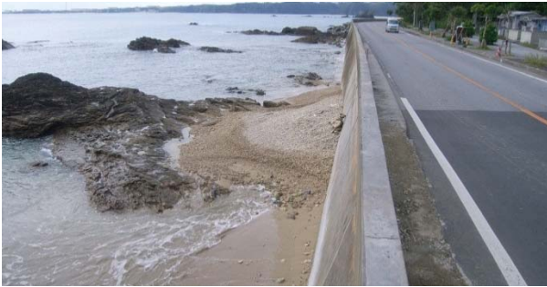
写真-5 B区間の直立護岸の整備区間
