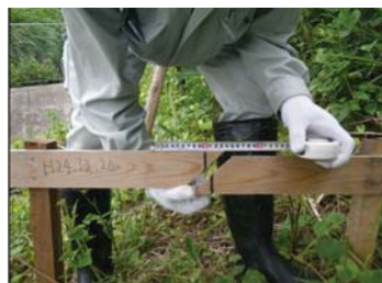
写真-20 抜き板変位(NK2)
