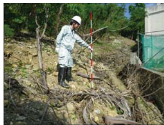
写真-4 Gブロック 舌端部
