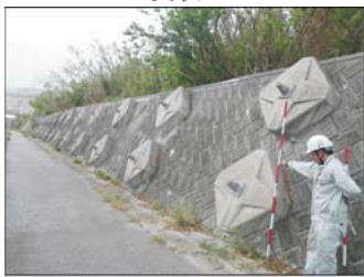
写真-3 Fブロック 間知ブロックの補強対策
