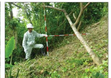
写真-10 頂部の傾斜
