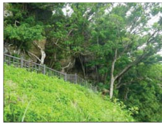
写真-2 Eブロック 岩の露呈
