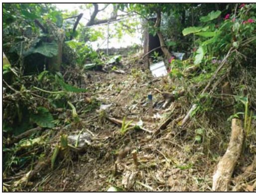
写真-21 Eブロック移動杭設置箇所
