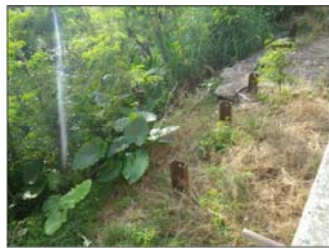
写真-6 Jブロック 抑止杭
