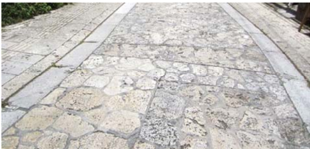
写真-5 石張り舗装および側溝の施工例
