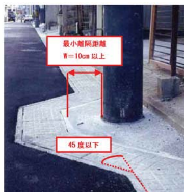
写真-8 柱の離隔距離および側溝切り回しの施工例
