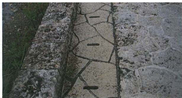
写真-6 型紙使用吹付工法の施工例
