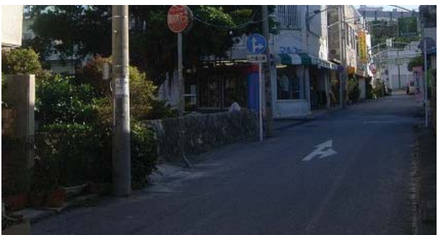
写真-7 通信柱・電力柱の設置状況
