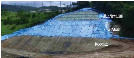
写真-1 切土法面の崩壊状況(全景)
