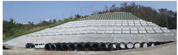
写真-5 グラウンドアンカー工による抑止工の完成状況
