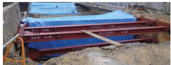
写真-3 支保工の設置状況
