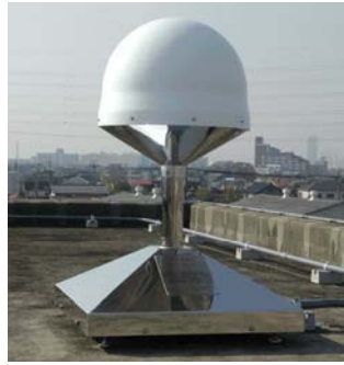
写真-3 GNSS 固定点(屋上型)
