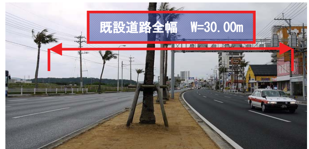
写真-1 既設道路の状況
