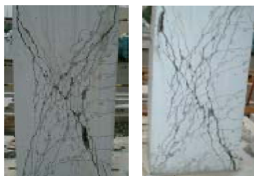
R10 試験体 R20 試験体 写真 1 損傷試験体のひび割れ状況
