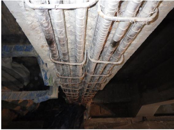
図-5 鉄筋はつり出し状況 (断面修復工法)
