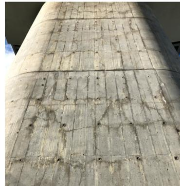
図-4 ひび割れ発錆状況図
