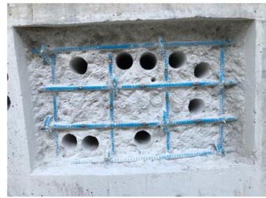
図-3 測定前のはつり出しおよび電解研磨の状況 (例)
