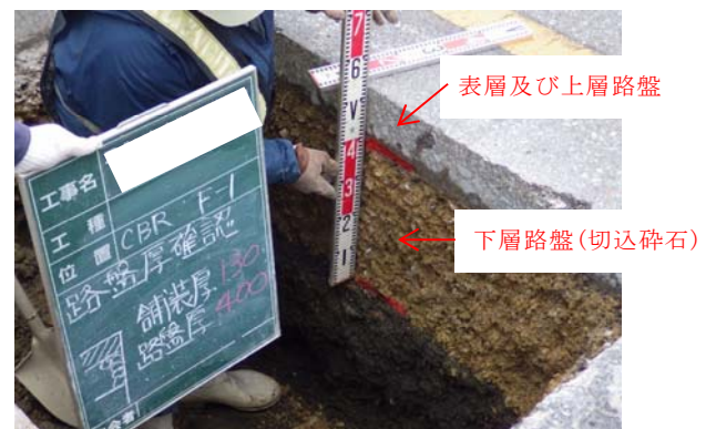
写真-4 下層路盤の状況
