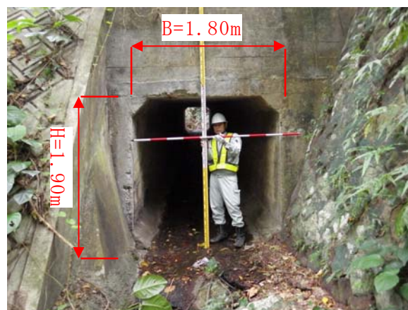
写真-1. ボックスカルバート吐口部
