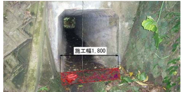
写真-6. 根固め工設置箇所
