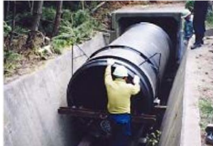
写真-4. 高耐圧ポリエチレン管挿入状況
