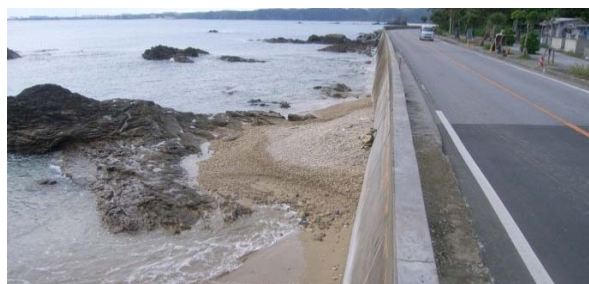
写真-5 直立護岸の整備状況
