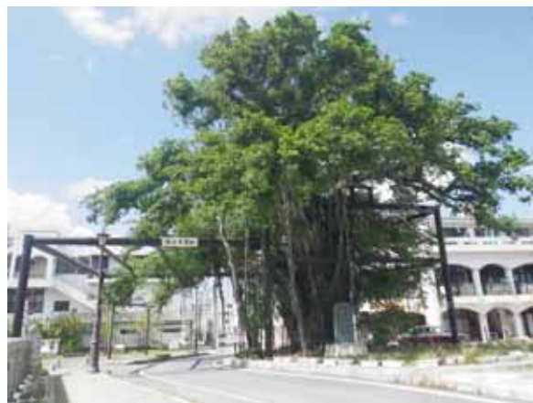
写真-3 倒木対策工 竣工状況
