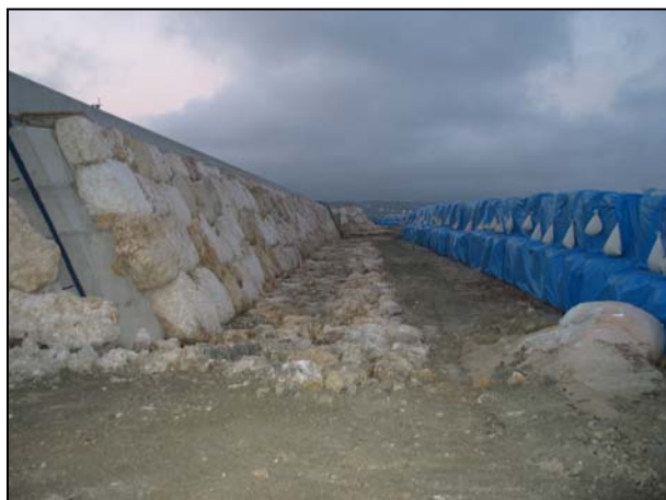
写真-2 外海との遮水完了の状況
