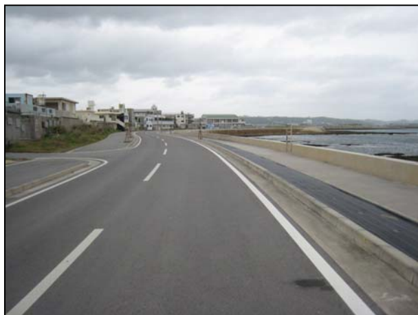
写真-3 完成後の状況
