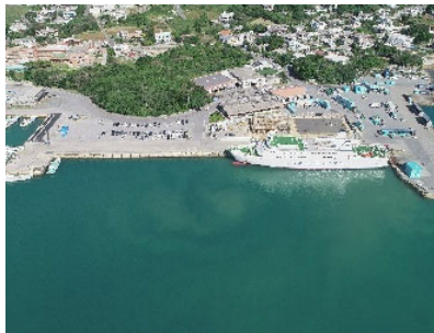
兼城港（兼城地区）岸壁（-5.5m）調査測量設計業務委託 （南部土木事務所）
