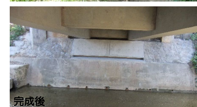
村道サトモ線1号橋修繕設計業務(R3) （伊是名村役場）
