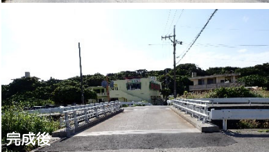
古島線1号橋修繕設計委託業務 （八重瀬町役場）
