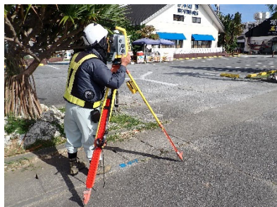
基準点測量 令和3年度南部国道管内改築関係 測量調査設計（その1）業務 (南部国道事務所)
