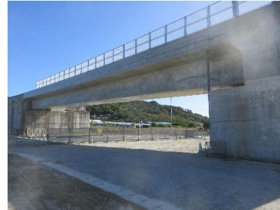
現場施工管理 R4 南部東道路現場技術業務委託 (その2) (南部土木事務所)
