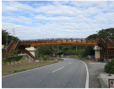
浦添大公園調査測量設計業務委託 (H27-1) (中部土木事務所)
