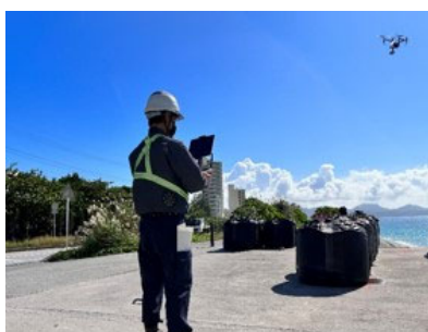
UAV 測量業務 国道449号災害防除測量設計 業務委託（R4） (北部土木事務所)
