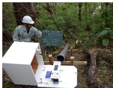
伸縮計設置状況 津覇急傾斜地調査測量設計業務 （中部土木事務所）
