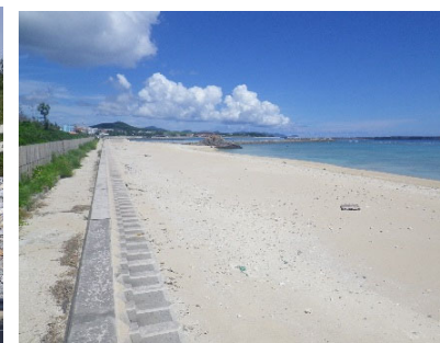
海浜復元・面的防護による高潮対策施設 仲田港（仲田地区）海岸調査測量設計業務委託（H24） （北部土木事務所）
