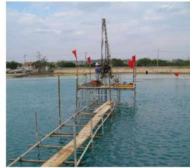
海上ボーリング調査 長山港(渡口地区)浮桟橋調査測量設計業務委託 (宮古土木事務所)
