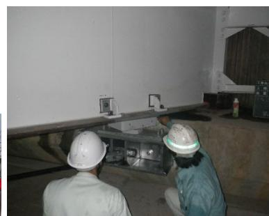
補修・落橋防止システム設置
