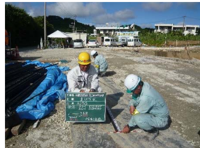
現場施工管理 現場立会い状況（フーチング鉄筋） H28 南部東道路現場技術業務委託 （南部土木事務所）
