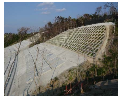
恩納南 BP 供用箇所法面崩壊対策 平成 24 年度改築事業箇所測量設計 （北部国道事務所）
