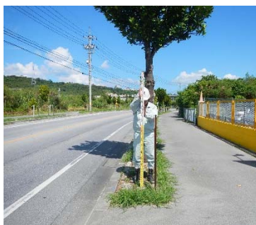
水準測量 豊原地すべり調査測量設計業務委託 （H27）（中部土木事務所）
