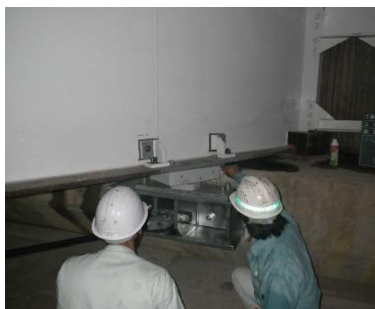
補修・落橋防止システム設置 名護本部線並里橋橋梁補修設計業務 委託（北部土木事務所）
