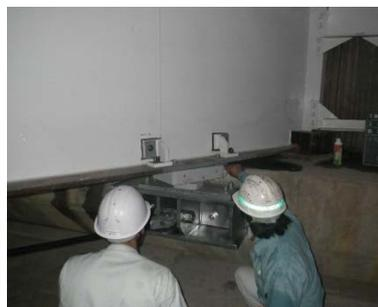
補修・落橋防止システム設置
